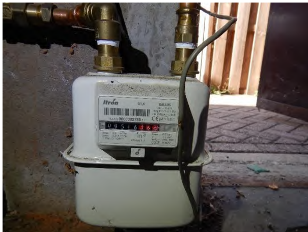
Gasmeter asbestvrij (2017)
