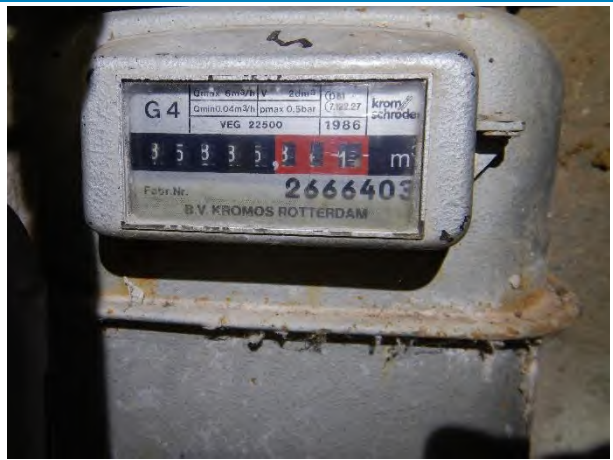
Gasmeter asbesthoudend
