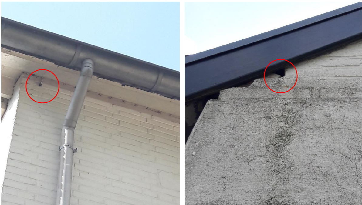
Figuur 5.1 Potentiele verblijfplaatsen (rode cirkels) gebouwbewonende vleermuizen.
