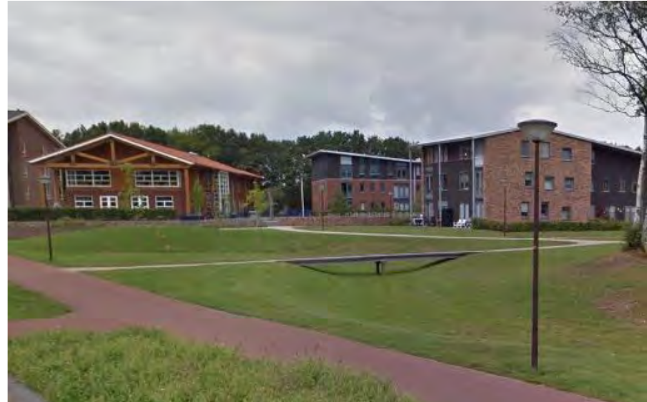
lichtmast aan het groen in Bijsteren
