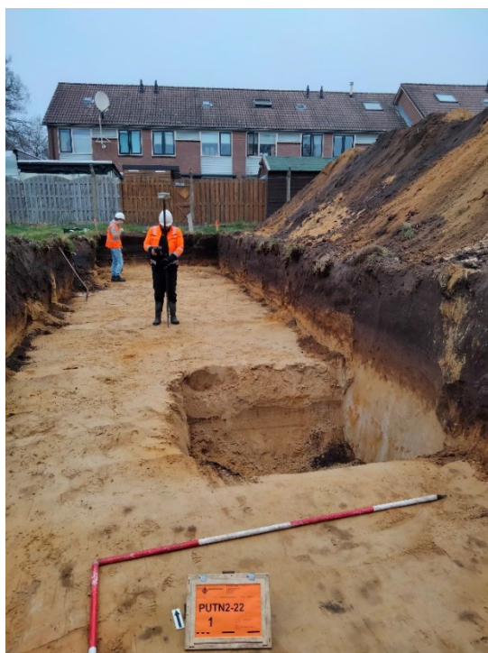
Afb. 7. Impressie van de werkzaamheden na de aanleg van het sporenvlak.
