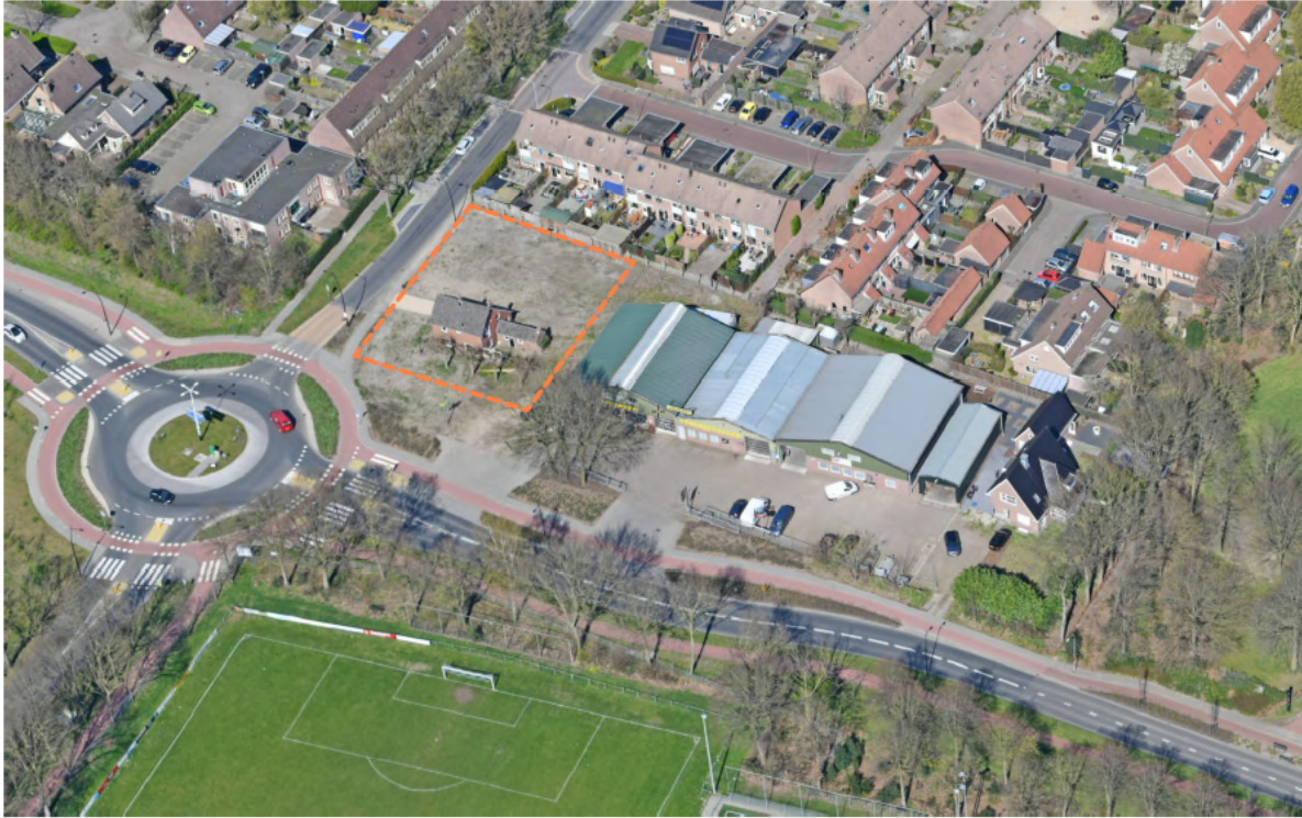
Figuur 3: Luchtfoto bestaand gebouw (bron google -bewerkt N.C.B. Projectrealisatie B.V.)
