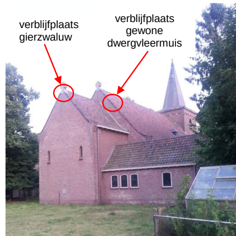
Figuur 2. Verblijfplaatsen in de kerk
