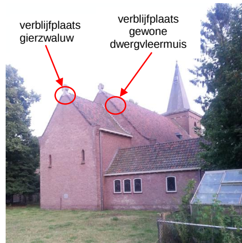
Figuur 2. Verblifplaatsen in de kerk
