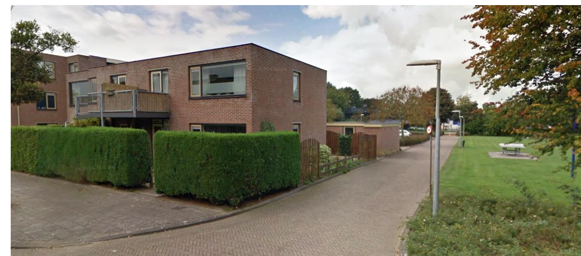
zicht vanaf Wallenbergstraat
