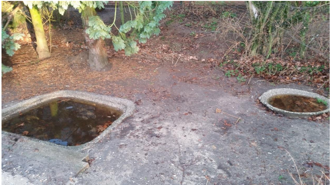
Figuur 6 Betonnen waterbakken komen verspreid over het plangebied voor
