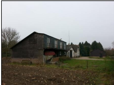
Figuur 3. Zuidwestelijk deel onderzoekslocatie met op voorgrond duiventil.
