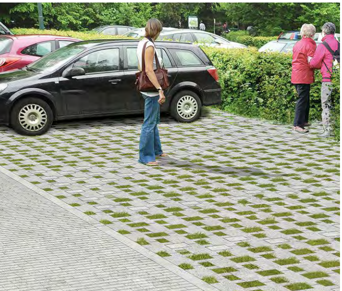
Parkeren in de hofjes en op straat met open bestrating uitgevoerd, zoals gras(beton)tegels
