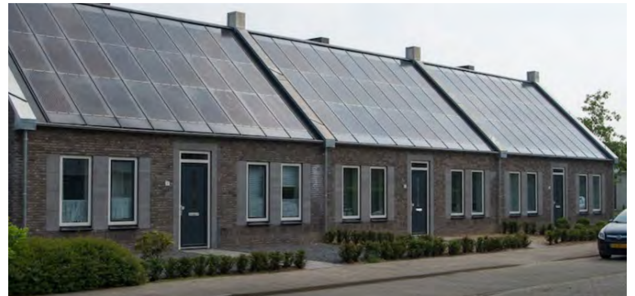
Grondgebonden woningen van één laag met kap
