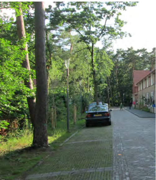
Parkeren in de hofjes en op straat met open bestrating uitgevoerd, zoals gras(beton)tegels
