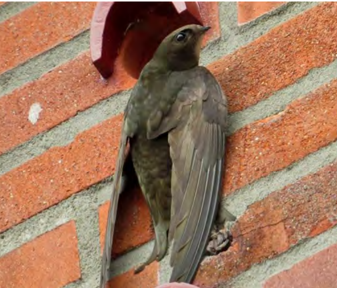
Gevelstenen waarin nestmogelijkheden voor de huismus, de gierzwaluw of voor insecten zijn
