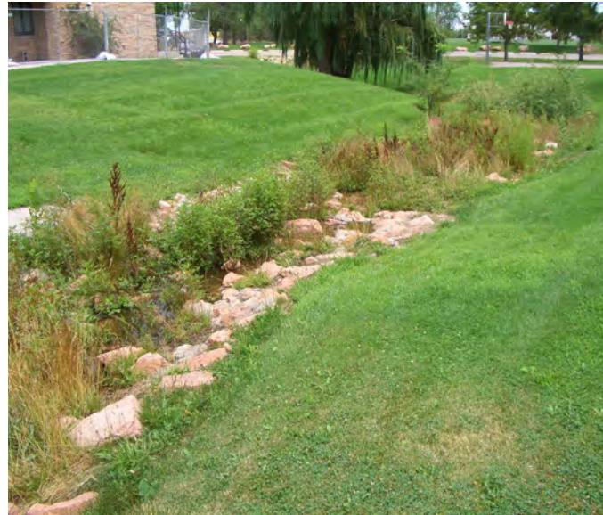
Ruimte voor wateropvang/-infiltratie in de wadi's
