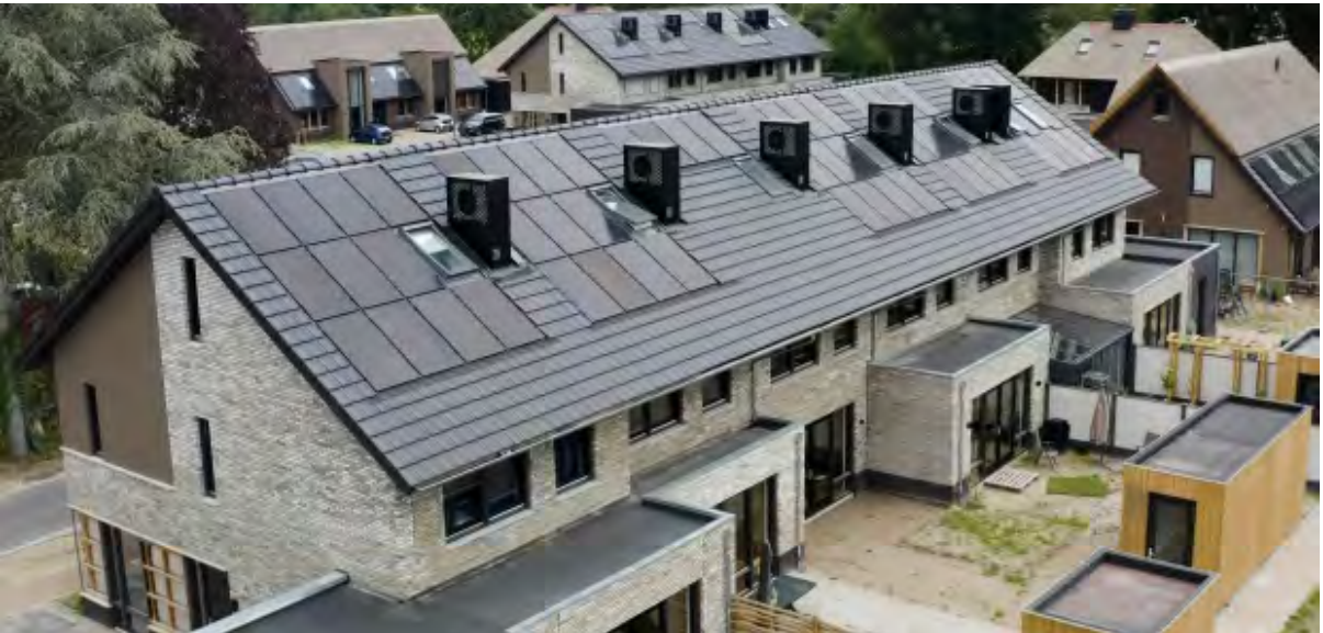
De warmtepomp buitenunits zijn als schoorstenen opgenomen
