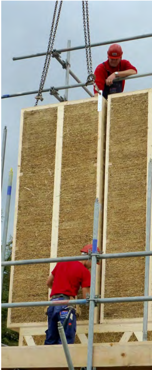
Eent prefab snelbouw-systeem dat bestaan uit 10% hout en 89% stro
