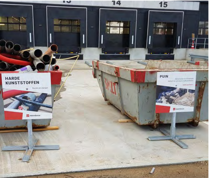
Gescheiden bouwafval op de locatie
