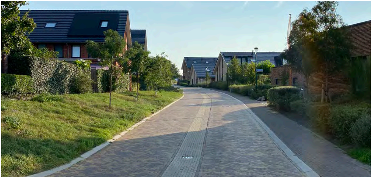
Straatprofiel wijkontsluiting: breed groenstrook met bomen, rijbaan van gebakken klinkers, verhoogd trottoir
