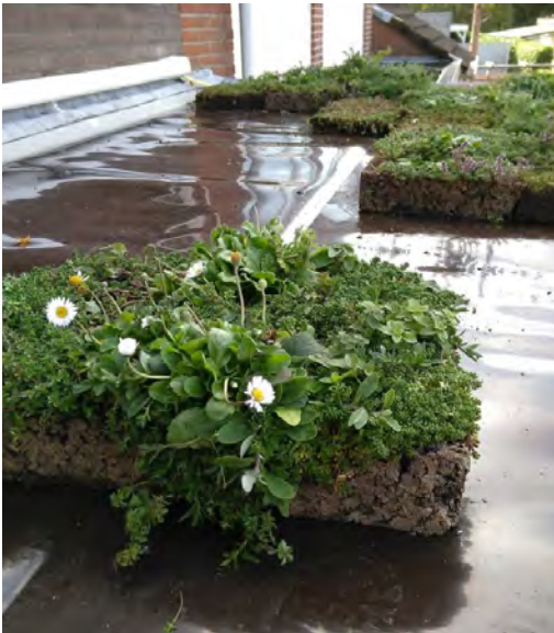
Biobased modules van geëxpandeerde kurk, als alternatief voor plastic trays
