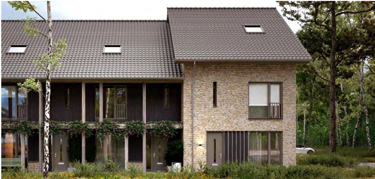
Dakverhoging aan het einde van het bouwblok
