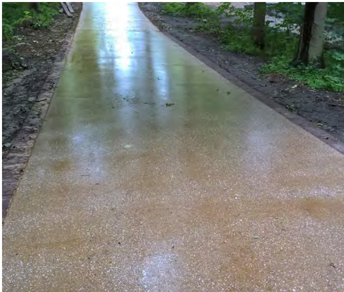
Fietsroute van asfalt (hier gele uitvoering met schelpen)
