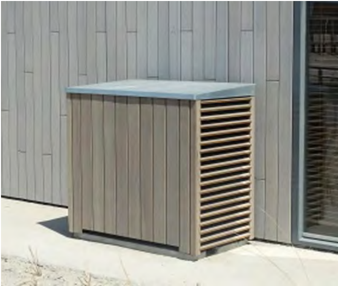
Kleur en materiaal van de omkasting van de warmtepomp buitenunits passend bij het gebouw
