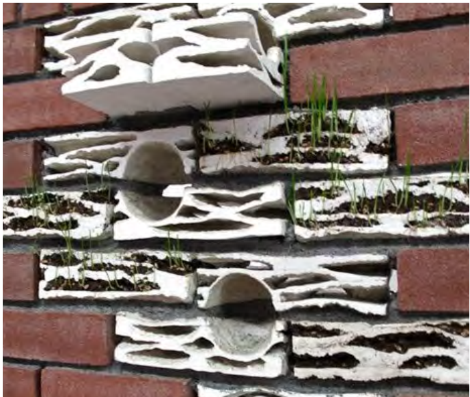
Gevelstenen waarin nestmogelijkheden voor de huismus, de gierzwaluw of voor insecten zijn
