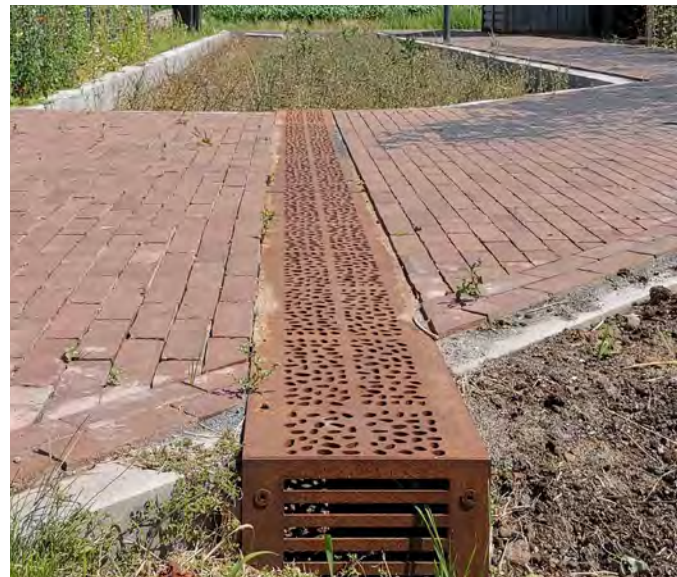
Afwateringvoorzieningen in bestrating opgenomen
