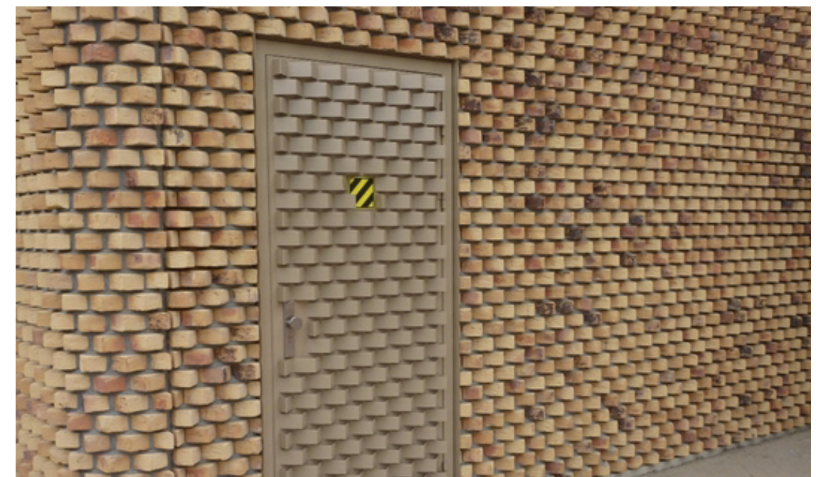
Transformatorhuis/nutskasten inpandig in appartementenblok
