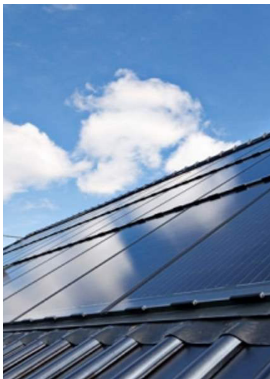
zonnepanelen als onderdeel van het dakvlak
