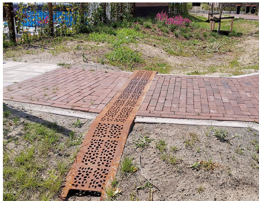
lijngoot (waar nodig), cortenstaal met motief
