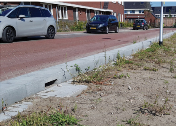
opsluitband met waterregulerende werking Wadigootband struyk verwo of vergelijkbaar
