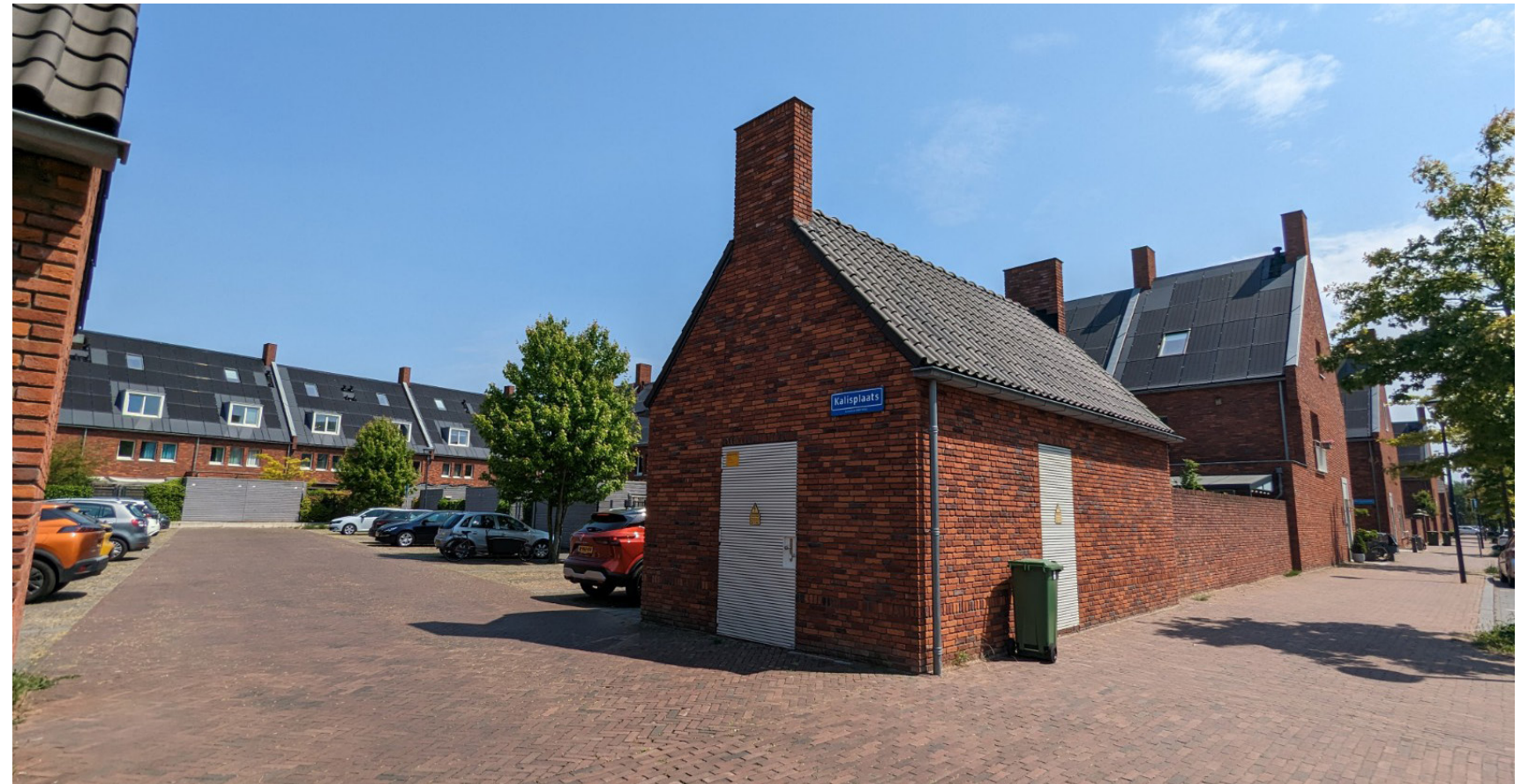
Transformatorhuis/nutskasten in samenhang ontworpen
