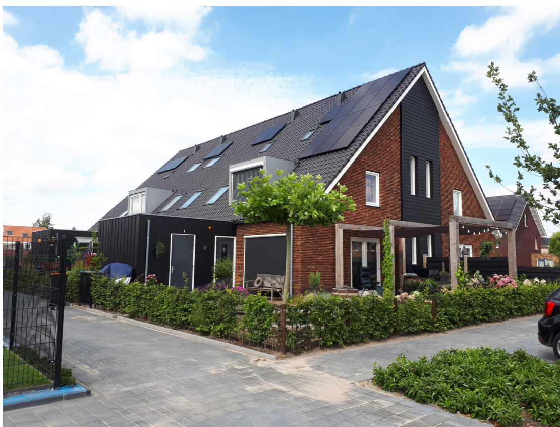
kopgevel ook 'levendig'
