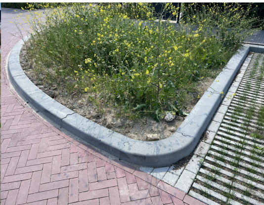
opsluitband met waterregulerende werking Wadigootband struyk verwo of vergelijkbaar
