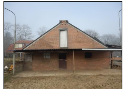
Figuur 5. Stenen schuur in gebruik als paardenstalling.
