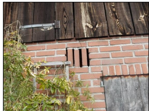
Figuur 12. Muurdeel voorzien van spouw en openingen.
