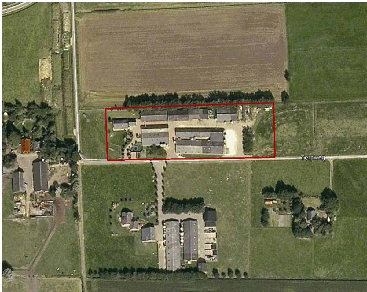
Perceel Terpweg 10 te Putten, bron: Google Earth
