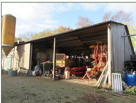
Foto's: Indrukken de te amoveren opstallen.
