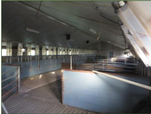
Foto's: Indrukken de te amoveren opstallen.
