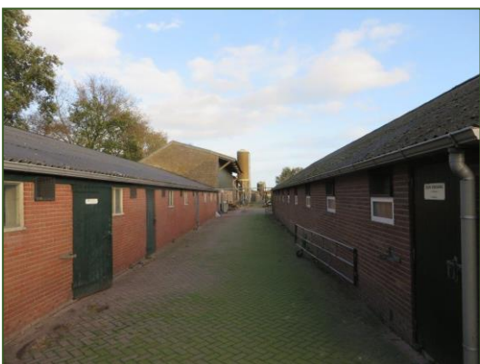
Foto's: Indrukken de te amoveren opstallen.
