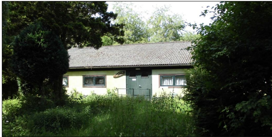
Sanitair gebouw, zijde Veenwaterweg
