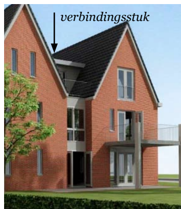
de verbindingsstukken liggen minimaal 4,5 m achter de rooilijnen van de zijvolumes, de bouwhoogte is maximaal 9,5 m
