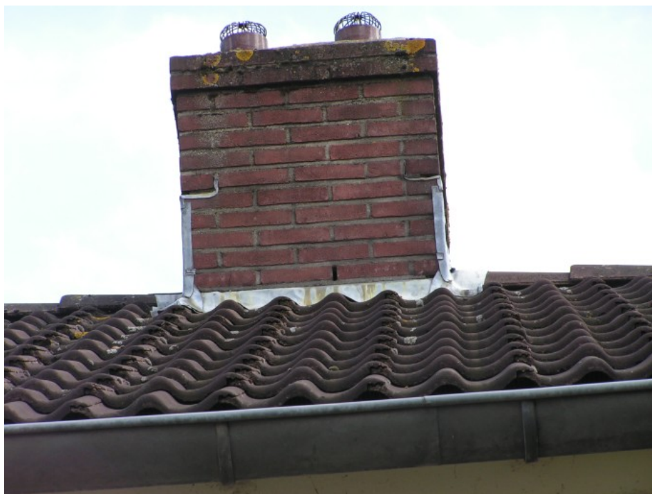
Figuur 2. Stootvoeg in een schoorsteen. Deze maakt de spouw toegankelijk voor vleermuizen.
