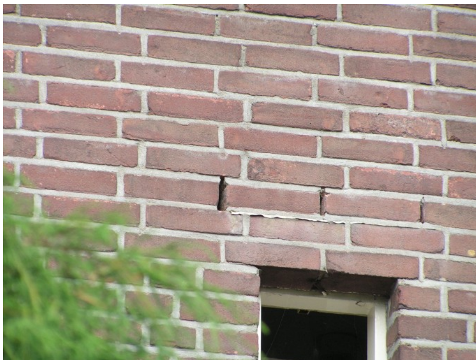
Figuur 6. Stootvoegen die toegang geven tot de spouwmuur.
