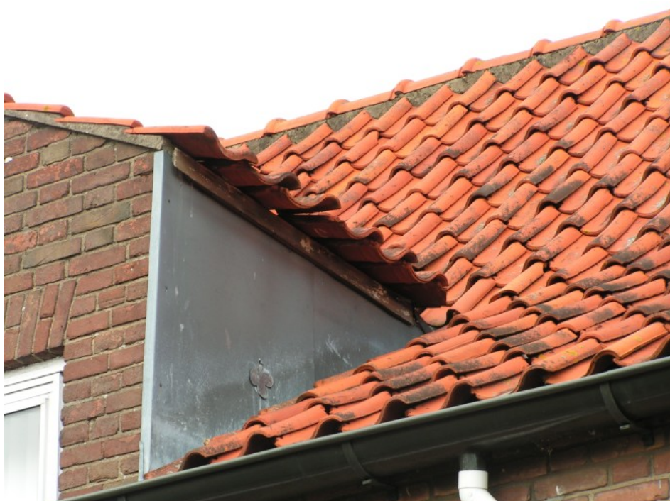
Figuur 3. Kierende dakpannen maken de daken toegankelijk voor huismussen en vleermuizen.
