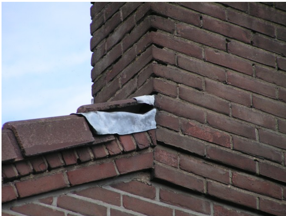
Figuur 8. Ruimte onder dakpan die toegang biedt aan vleermuizen en vogels.
