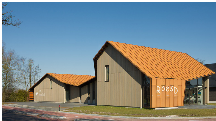
Hoofdgebouw met dakvlakaccenten
