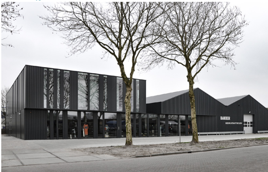
Hoofd- en bijgebouw als helder ensemble met verbijzondering van het dakvlak
