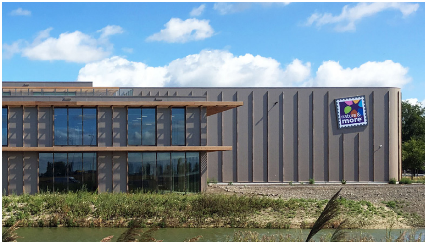
Hoofd- en bijgebouw vormen architectonisch ensemble
