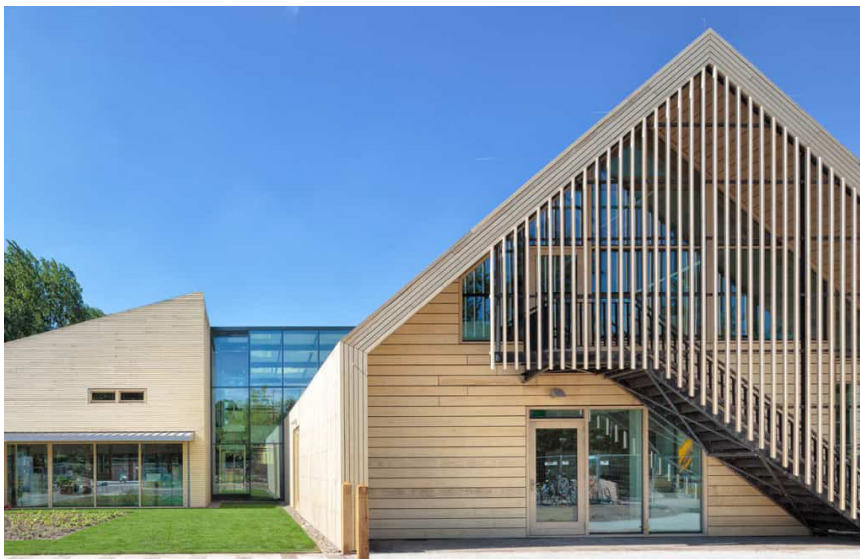
Markante bebouwing en architectuur met verbijzondering dakvlak
