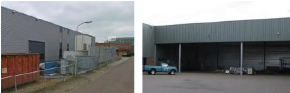
Afbeelding 6. Geen opslag vóór de voorgevel van een gebouw (foto links), maar in een gebouw (foto rechts) of op het zij- of achtererf (bron: Notitie beeldkwaliteit revitalisering Keizerswoert).
