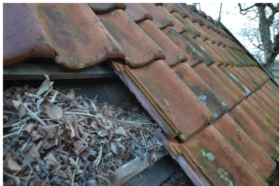
Onder dakpannen is ruimte voor huismussen
