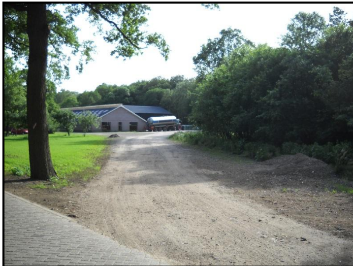
Figuur: zicht op nieuwe inrit vanaf Huddingweg in zuidwestelijke richting
