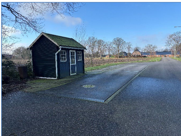
Toerit Beitelweg middels geasfalteerde weg met eigen weegbrug en weeghuisje
