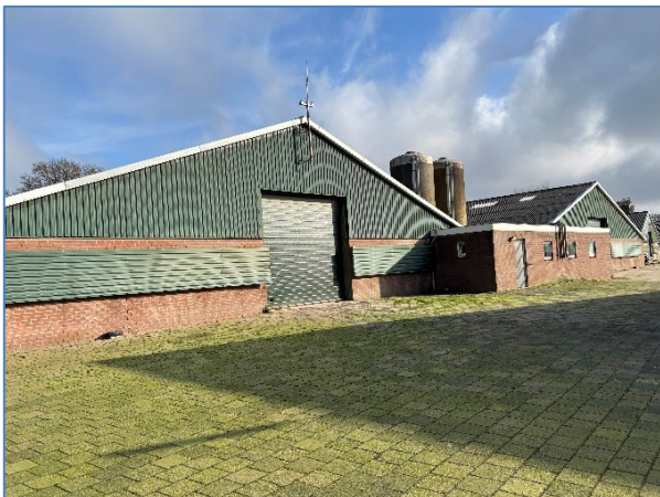
Pluimveestal 2 en 3 met hygiënesluis
