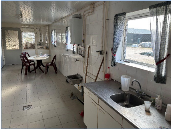
Hygiënesluis met kantine/kantoorruimte, toilet en douche
