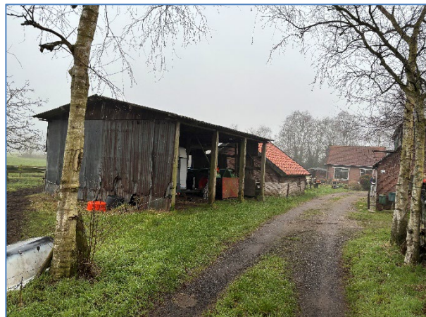
Onverharde oprit met houten opstal
