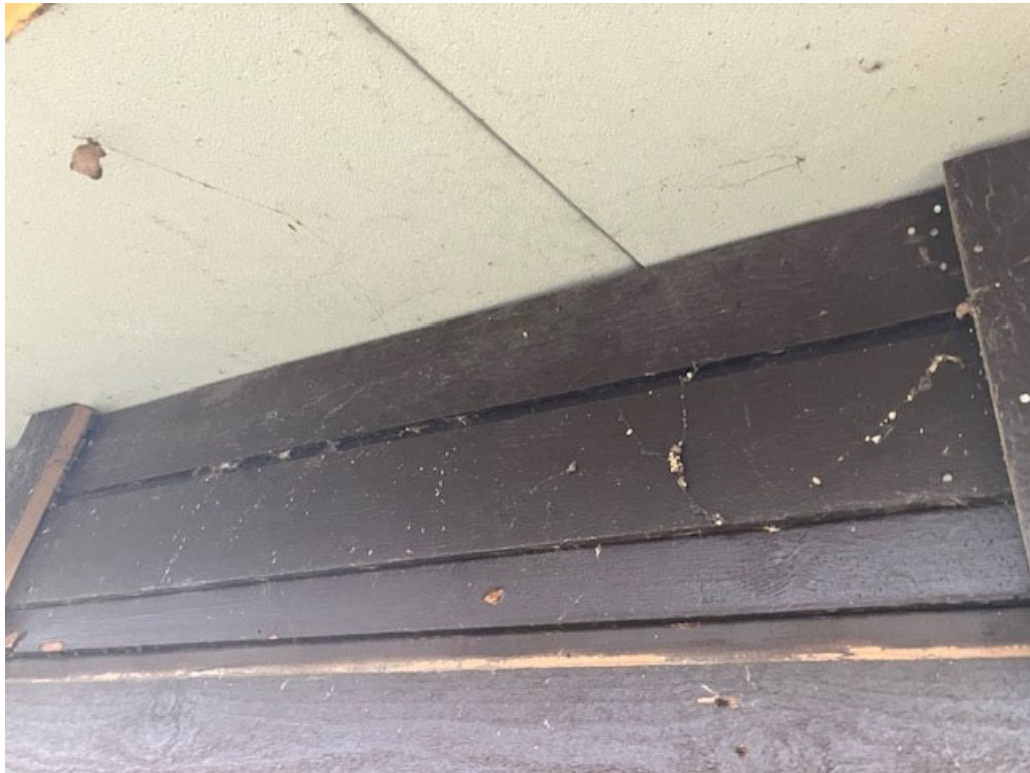
• Afbeelding 15: aansluiting gevel varkensstallen op onderzijde dak, geen naden
