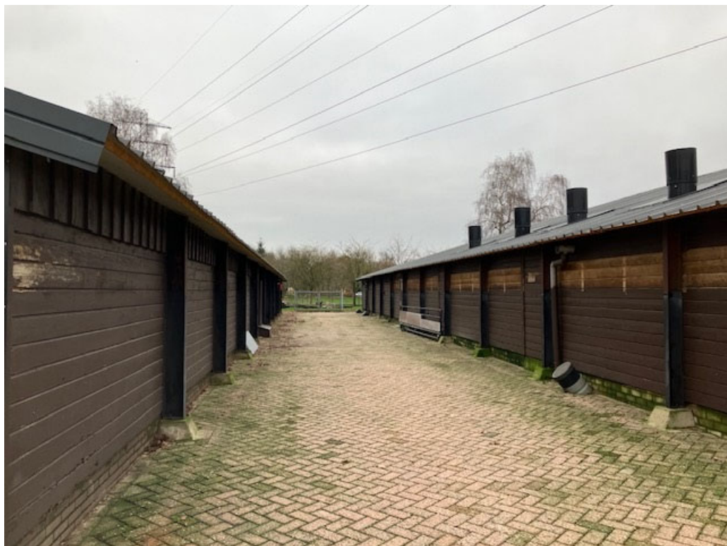
• Afbeelding 16: verharding tussen de varkensstallen aan de Oude Nijkerkerweg, gevels van hout, sandwichpanelen dak
