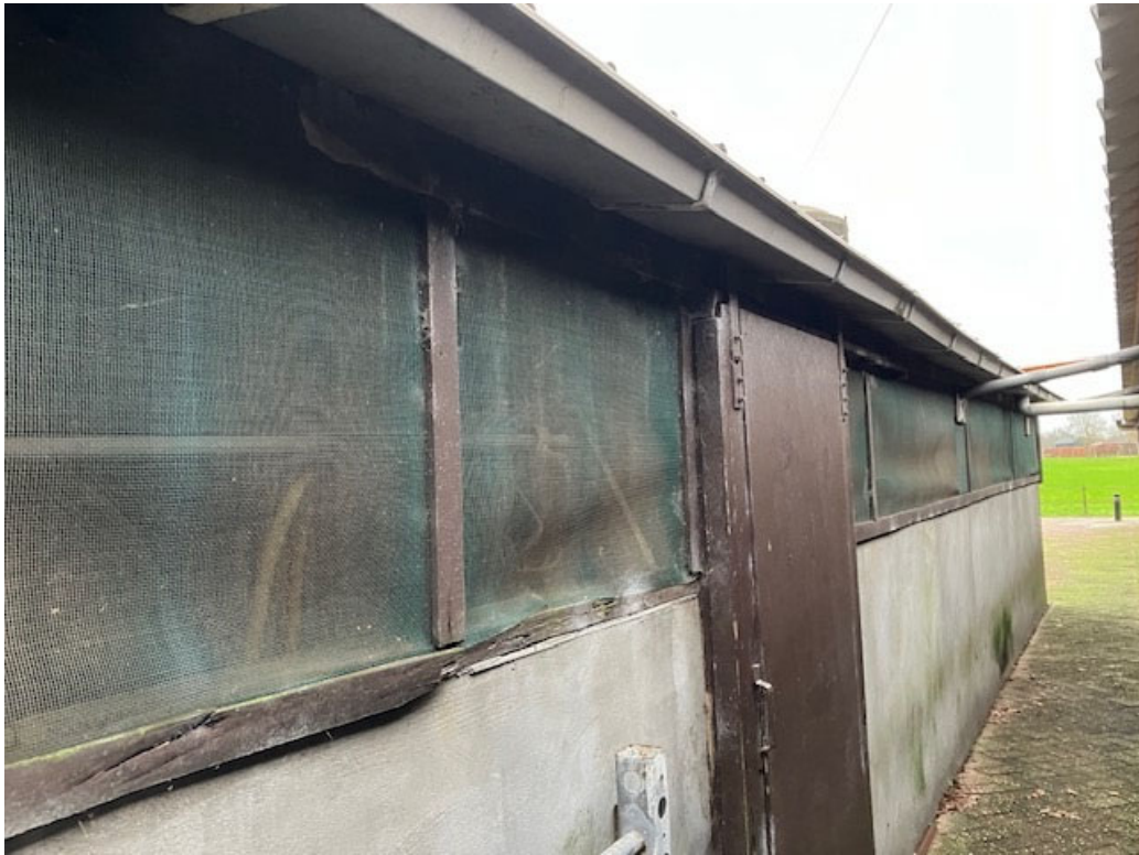
• Afbeelding 9: Opslag schuur, geheel dicht
