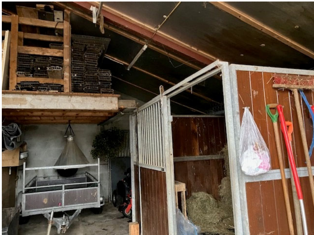
• Afbeelding 11: binnenzijde schuur met paardenstal (wordt gesloopt)
