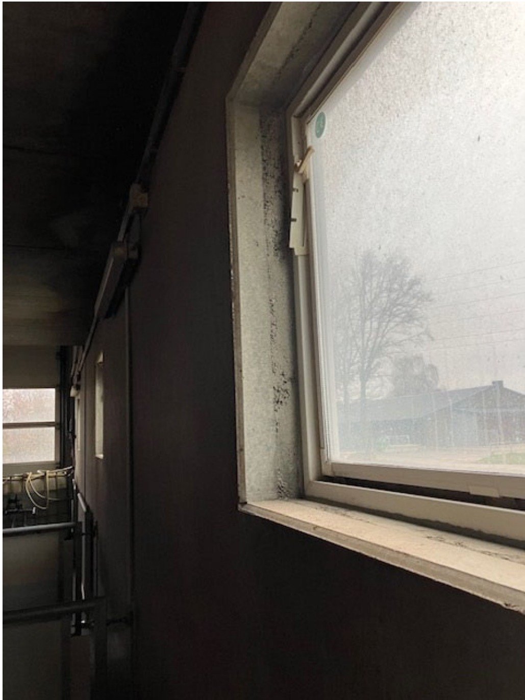
• Afbeelding 6: kozijnaansluiting in de stal aan de Blarinckhorsterweg
