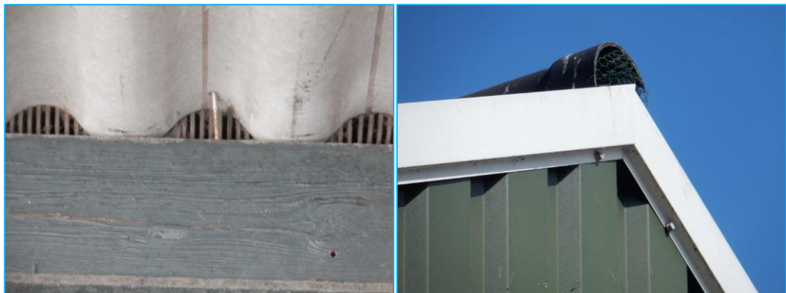
Foto's: Enkele voorbeelden van de vele vogelwering in/ aan de opstal.
