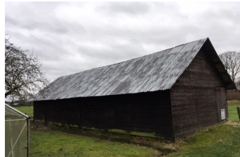
Figuur 3.3 Jongveestal 2 (bron: FF Solutions)
