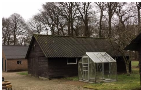
Figuur 3.5 Jongveestal 1 (bron: FF Solutions)
