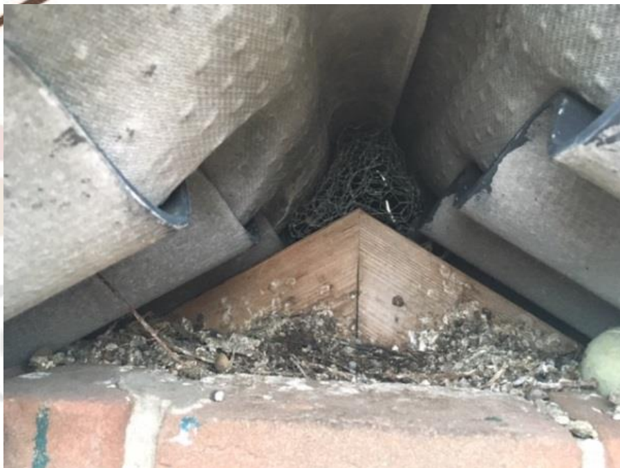
Duivennest voorzijde nok varkensstal (bron: FF Solutions)
