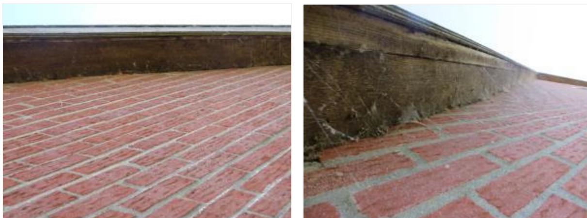
Afbeelding 5.1: Nauw aansluitende daklijsten van de pluimveestal. Foto: Natuurkompas, 2019.
