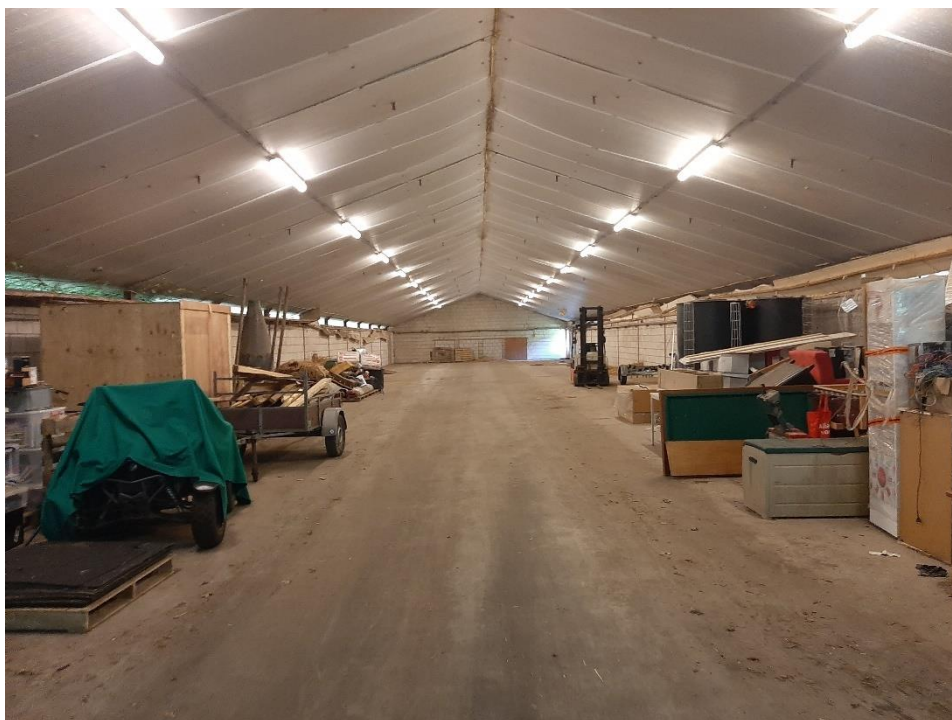
Foto 7; binnenzijde voormalige kippenschuur
