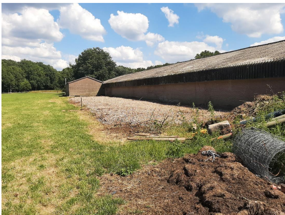
Foto 6; weide ten noorden van de schuur
