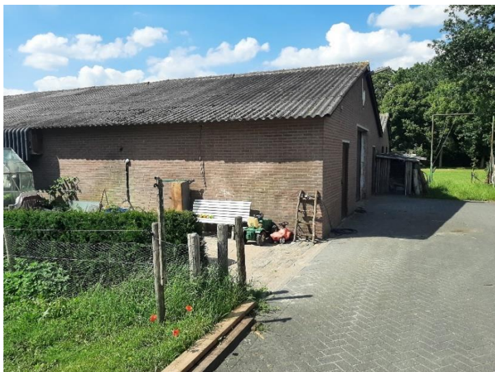
Foto 1; voormalige kippenschuur voorzijde
