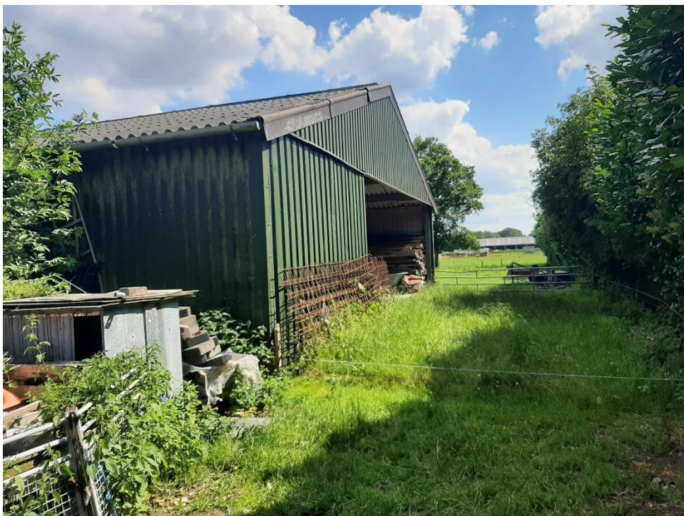
Foto5; achterzijde met bestaande houtwal
