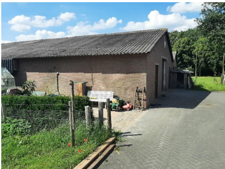
Foto 1; voormalige kippenschuur voorzijde
