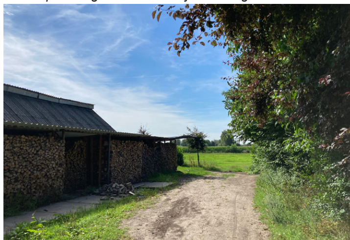
Te slopen overkapping westzijde perceel
