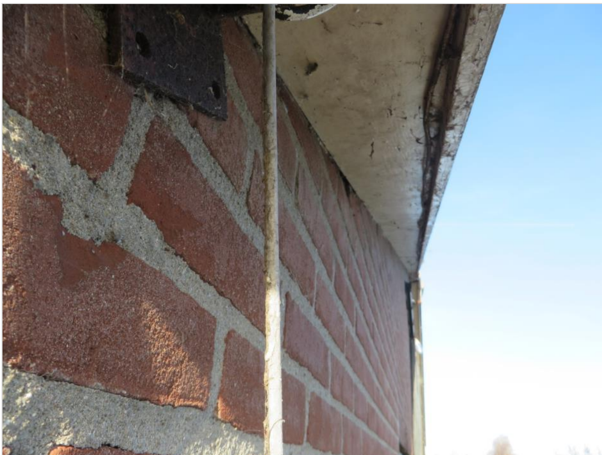
Afbeelding 5.1: Nauw aansluitende gevelbetimmering van de ligboxenstal. Foto: Natuurkompas, 2019.
