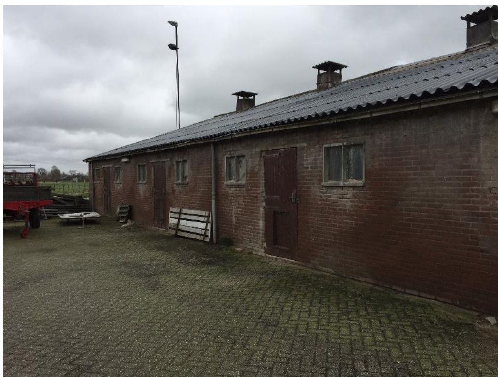
Figuur 2 Een van de stallen betreft een voormalige varkensstal en is opgetrokken uit gemetselde muren en een golfplaten dak.
