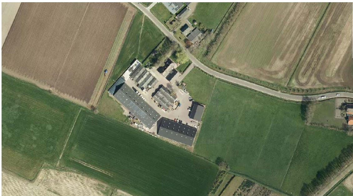
Figuur 1: Huidige situatie Zuiderzeestraatweg 23 (Luchtfoto gemeente Putten 2015)
