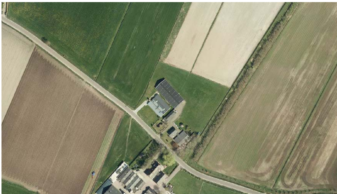
Figuur 2: Huidige situatie Zuiderzeestraatweg 24 (Luchtfoto gemeente Putten 2015)
