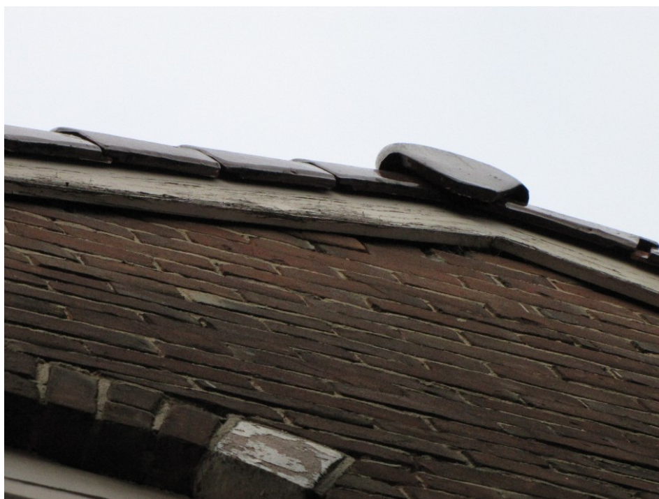
Figuur 3. Ruimte tussen de daklijst en de muur die de spouwmuur toegankelijk maken voor vleermuizen.
