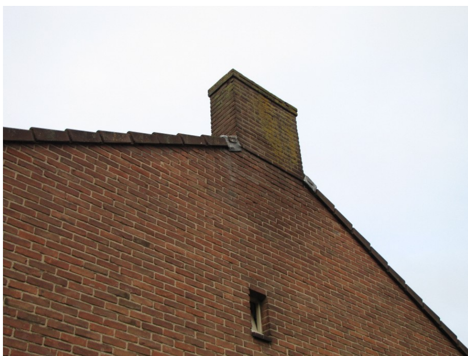
Figuur 5. Eindwoning met overhangende dakpannen, geschikt als nestgelegenheid voor gierzwaluwen.
