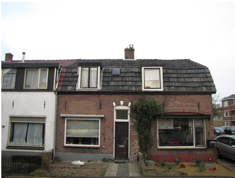
Figuur 4. Huis met mansarde dak, geschikt als nestgelegenheid voor huismus en gierzwaluw.
