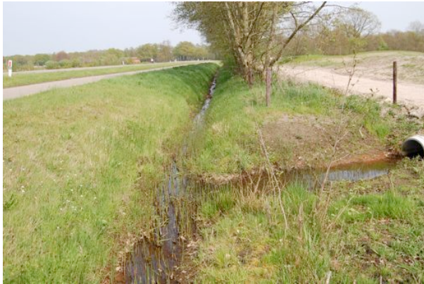
bermsloot met duiker langs N789
