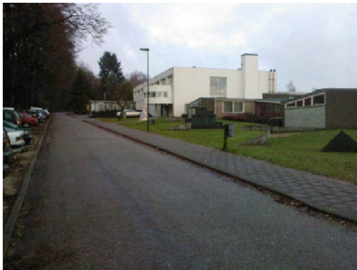
Afbeelding 9 Kleiburglaan, school gezien vanuit het zuidwesten
