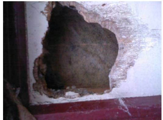
Afbeelding 11 Kleiburglaan, mogelijk asbest in noodgebouw
