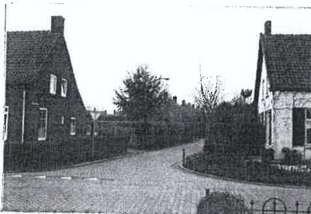
3. De bebouwing aan de zuidzijde van de Kerkwijk is kleinschalig van karakter. Hier is de situatie weergegeven op de hoek Oegsteegsestraat/Kerkwijk.
