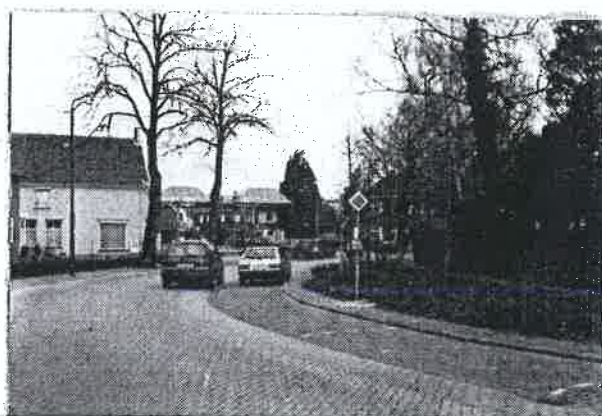
2. Deze uitsnede van de Hoogstraat heeft een zekere ruimtelijke kwaliteit. Er is een onduidelijke verkeerssituatie ontstaan vanwege de parkeerstrook aan de noordzijde van de weg.
