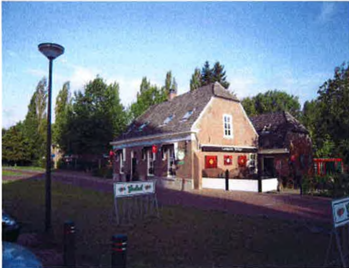
Torenstraat 4: straks historische kwaliteit in een nieuwe sedenbouwkundige setting
