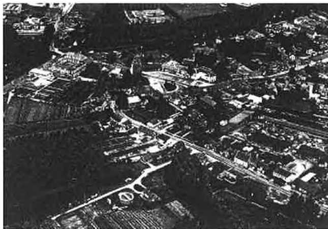
Luchtfoto dertiger jaren
