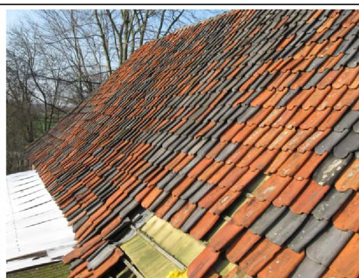
Foto: dak hoofdgebouw (achterzijde)
