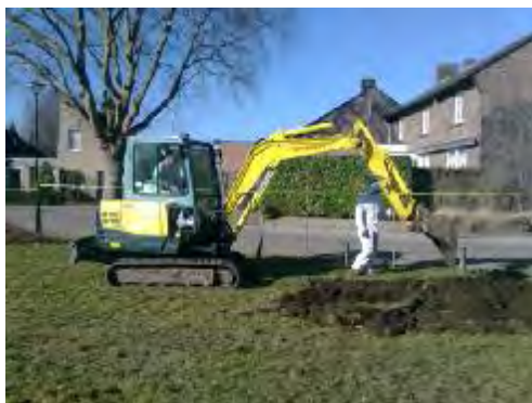
Foto 7. Graven asbestsleuven
