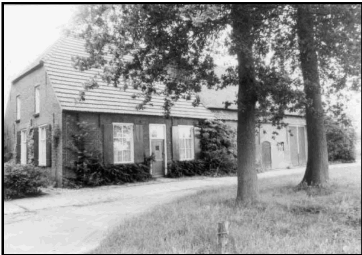
Figuur 7: De in 1900 gebouwde boerderij aan de Duifhuisstraat 7 te Sint-Michielsgestel. Deze boerderij werd aangemerkt als monument van cultuurhistorische waarde door het Monumenten Inventarisatie Project (MIP).
