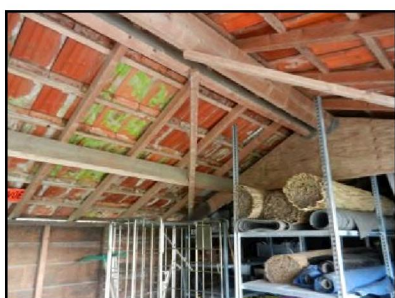
Figuur 6. Binnenzijde één van de schuren.
