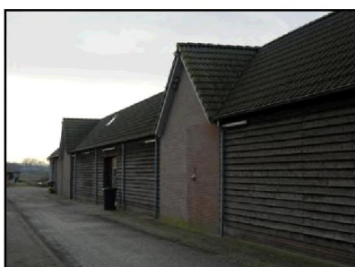
Figuur 7. Gevel van het bedrijfsgebouw.
