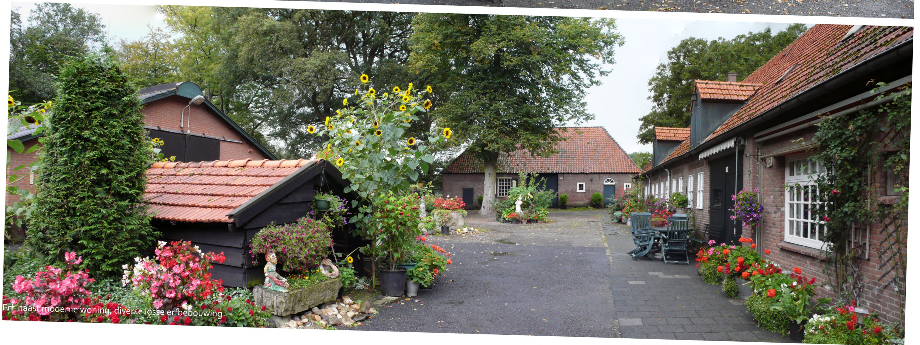
Zuidgevel boerderij aan erf met Vlaamse schuur
