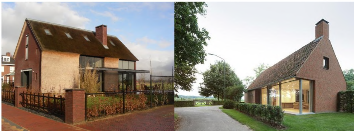
Figuur 10, opengewerkte gevels aan voor- en zijgevels woningen
