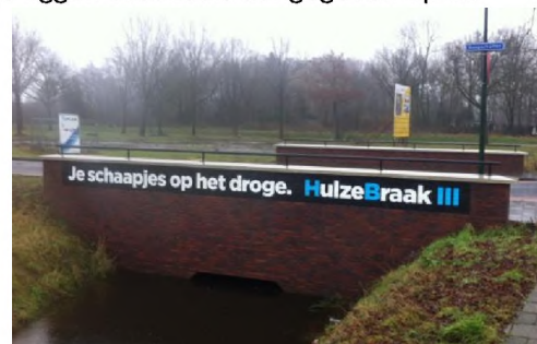
Figuur 8, voorbeeld duiker met muur
