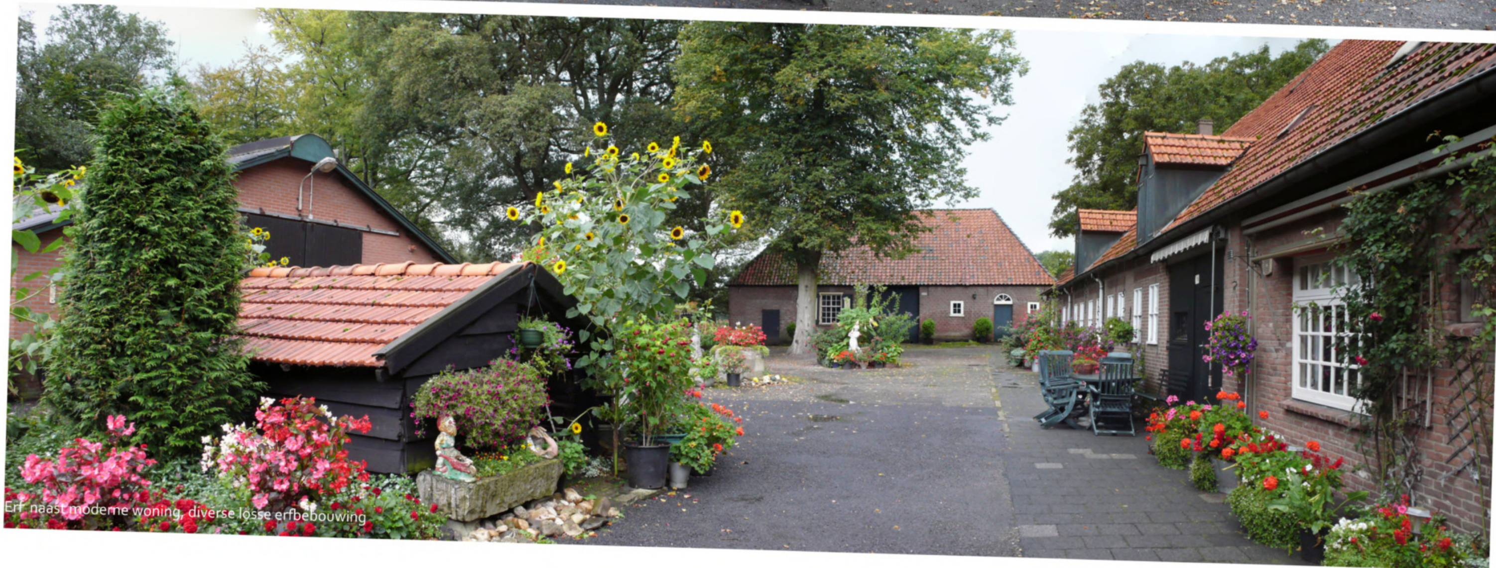
Zuidgevel boerderij aan erf met Vlaamse schuur
