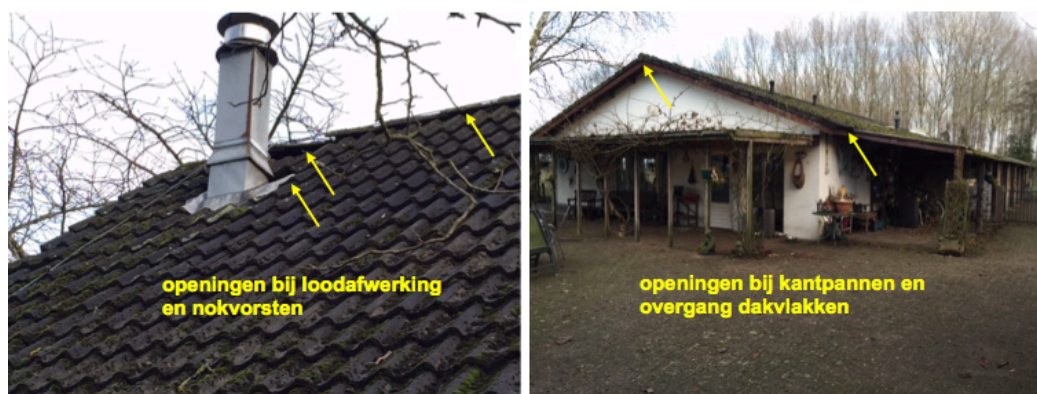
Figuur 2 De daken van de woning en achtergelegen schuur bieden diverse potentiële verblijfplaatsen voor onder andere gewone dwergvleermuis en laatvlieger.
