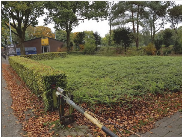
Figuur 5. Clubgebouw waar rechtsvoor een deel aangebouwd wordt. De bomen voor het gebouw worden verwijderd.
