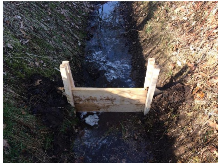
Figuur 34. Tijdelijke drempel met houten planken. Bij wateroverlast kunnen deze worden opgezet om water versnel af te voeren.
