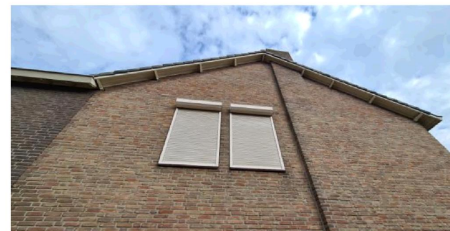
Figuur 5: Detailopname van de zuidgevel
