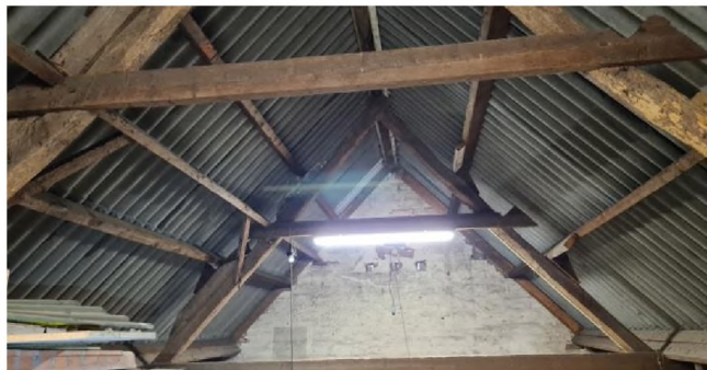
Figuur 8: Ruimte boven noordelijke koelcel
